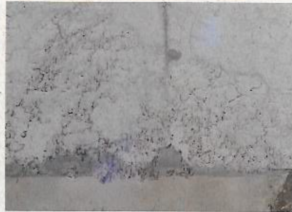
Fotografía N° 22: Nido en el dintel de la puerta de acceso sur al patio central del pabellón B, específicamente en el eje BD, entre los ejes B12 y B13 (vista cercana).
