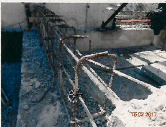
Fotografía N° 11: Enfierradura del sobrecimiento torcida y doblada, ubicada en el eje HH (entre H16 y H17) del pabellón H.
