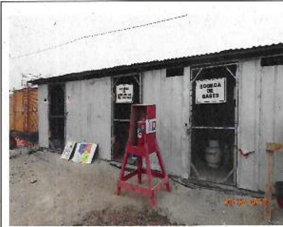
Fotografía N° 35: Extintor a la intemperie sin puerta de vidrio en su gabinete.
