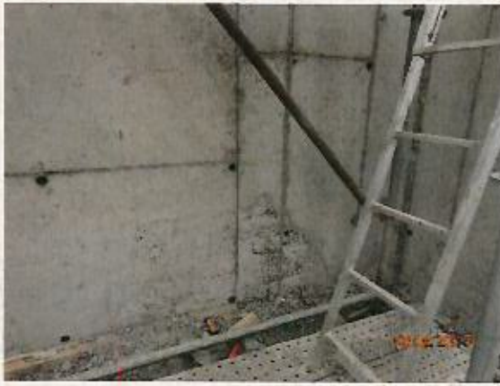
Fotografía N° 19: Segundo nido con enfierradura a la vista en muro del pabellón A, en el eje A2, entre los ejes AA y AB (vista general).
